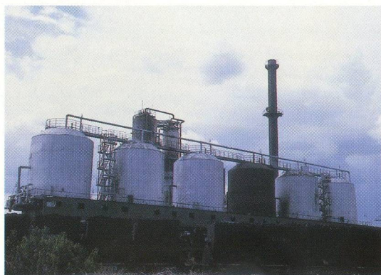
Установка по производству битума
