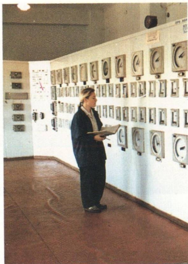
Щит установки N 50
